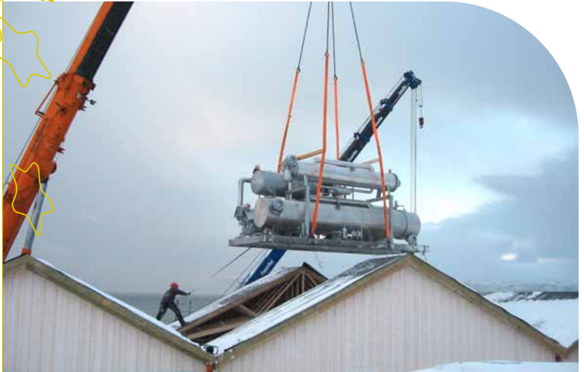
Varmepumpen heises på plass i fyringssentralen nede ved fjæra på Brekstad.
